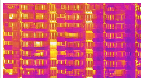
Modélisation thermique de la façade d'un immeuble locatif composée d'une centaine de prises de vues. Bâtiment datant des années 1980, dans la région lémanique. Heliotherm
