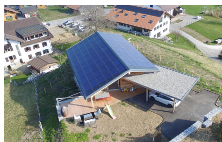
1 La villa de la famille Meuwly avec l'installation PV intégrée au toit.
