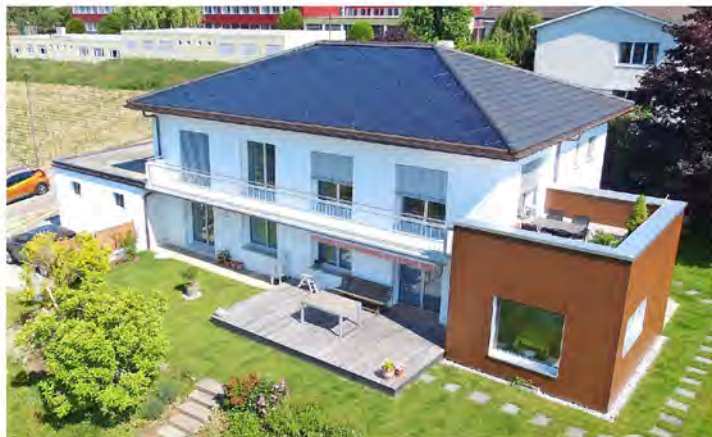
Luftaufnahme des Hauses: Von oben ist die ins Süddach integrierte Solaranlage gut sichtbar.
