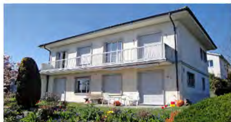
Das Einfamilienhaus vor der Erneuerung, die im Jahr 2018 stattgefunden hat.
