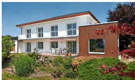
Ansicht vom Garten aus: Der neu angebaute Kubus (rechts) schuf für die obere Wohnung eine Terrasse und für die untere ein grosszügiges Esszimmer.
