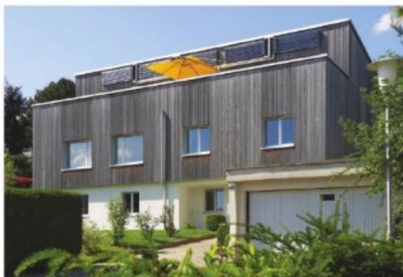
Photo 2.32 Revêtement bois de la surélévation, façade sud Crédit photo : C. Cuendet
