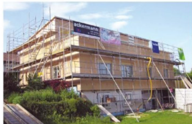
Photo 2.35 Isolation par éléments à ossature bois
