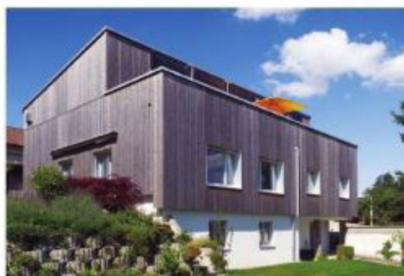
Photo 2.29 La maison après travaux de rénovation et surélévation Crédit photo : C. Guendet
