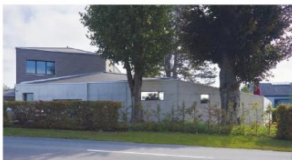
Photo 2.23 Un mur en béton côté route pour le confort acoustique et des arbres à feuilles caduques pour le confort d'été
