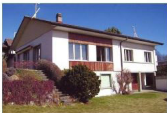
Photo 2.28 La maison avant travaux Crédit photo : Lutz Architectes
