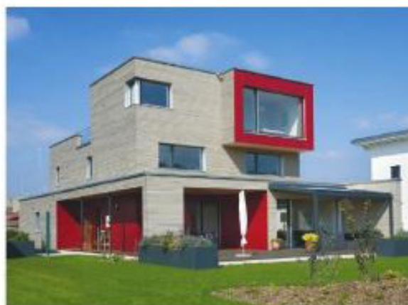
Photo 2.27 Façades sud et ouest Crédit photo : C. Guendet
