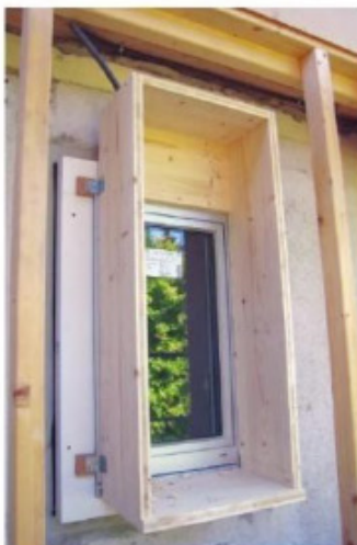
Photo 2.35 Isolation par éléments à ossature bois
