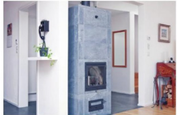
Photo 2.33 Le fourneau en pierre ollaire : appoint pour le chauffage et l'ECS
