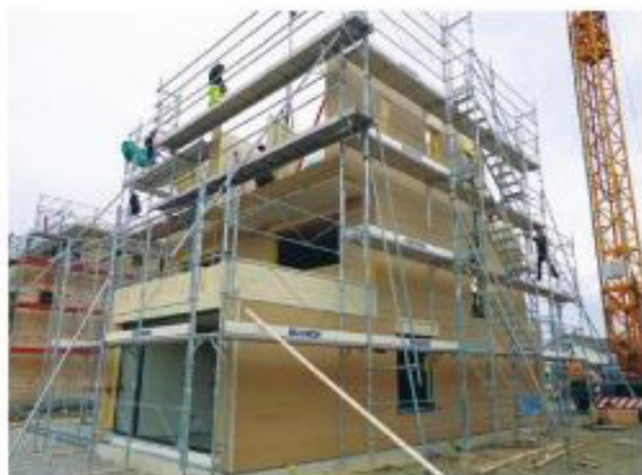
Photo 2.26 Une construction en ossature bois qui n'a duré que 8 semaines Crédit photo : Lutz Architectes
