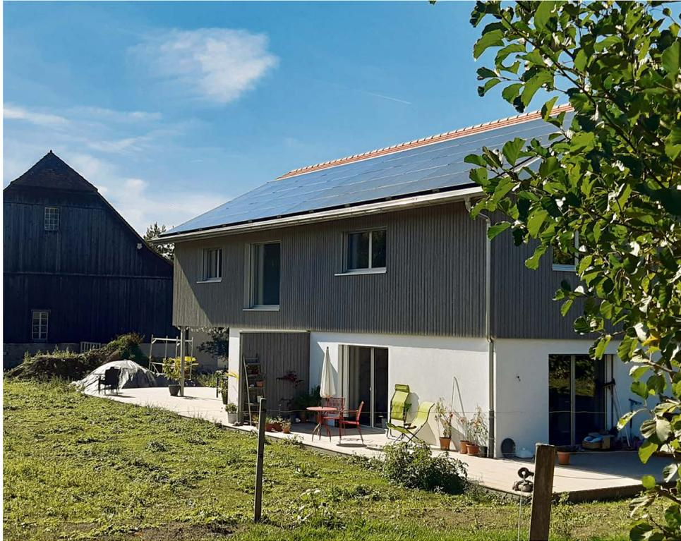
Panneaux photovoltaïques, cuve pour capter les précipitations, toilettes sèches: cette villa labellisée Minergie-P a été pensée pour être particulièrement efficiente.
