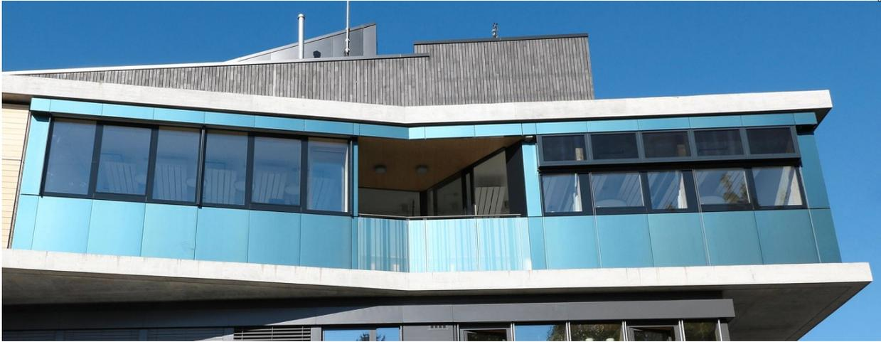
Les façades au reflet bleu de l'unité SolAce dissimulent des cellules photovoltaïques (électricité) et capteurs thermiques (eau chaude) qui suffisent à alimenter en énergie l'appartement de 100 m<sup>2</sup>.
