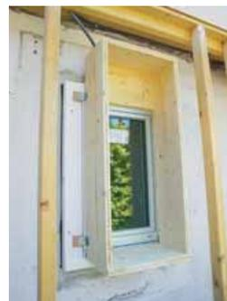
**Revêtement de façade en bois:** Les façades en pin blanc non traité sont munies d'un système de ventilation qui permet à l'humidité de s'évaporer très rapidement et de prolonger leur durée de vie.
