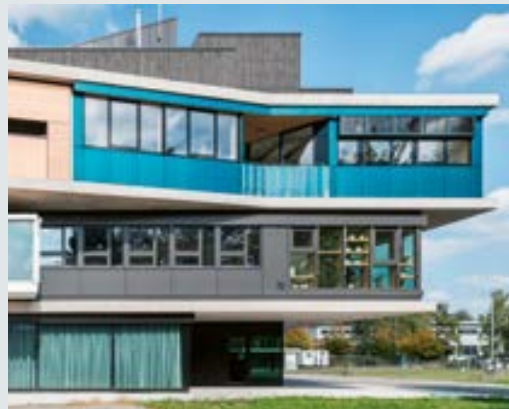
Façade sud de l'unité SolAce au NEST à Dübendorf équipée de panneaux solaires photovoltaïques colorés (Kromatix) / Lutz Architectes, EPFL. © Roman Keller
